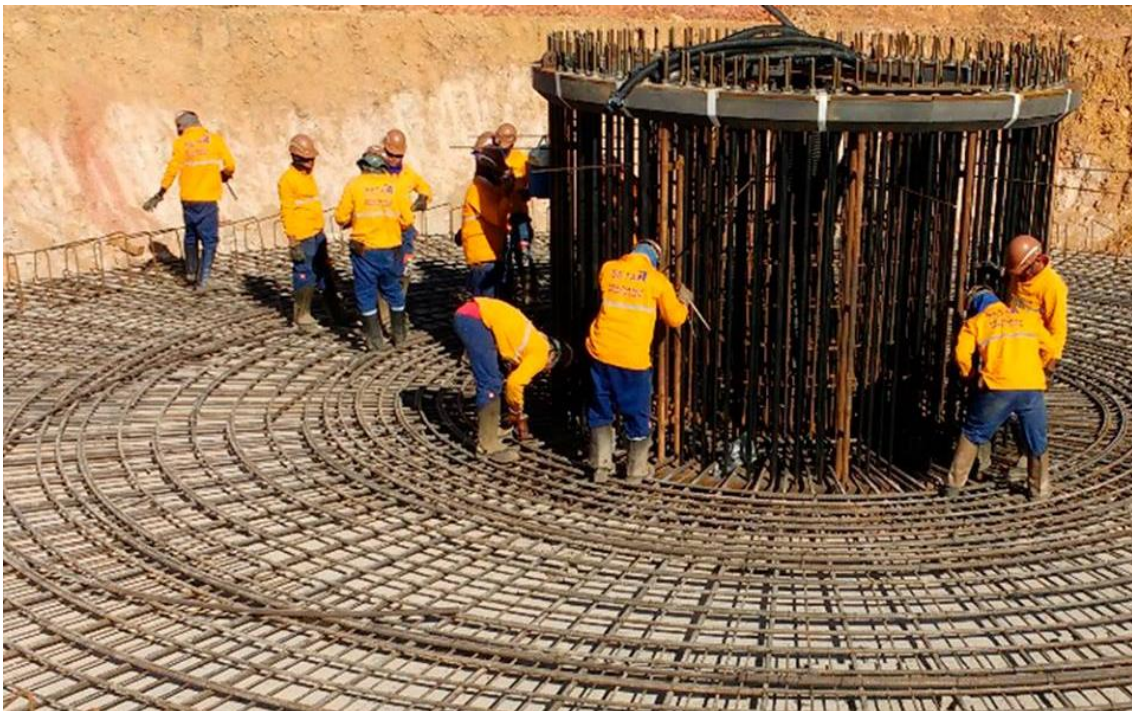
Figura 4. Equipe de armação: montagem do bloco.
